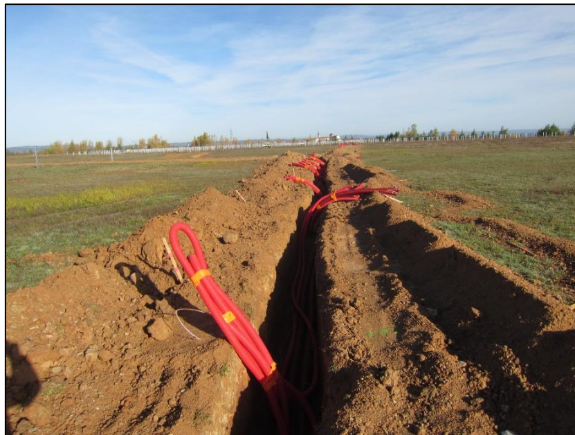
Photo 2 : Exemple de tranchée et pose de câbles dans des fourreaux
